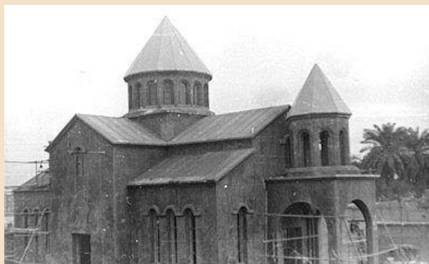
عکس‌های کمتر دیده‌شده از کلیسای آبادان، در حال ساخت
